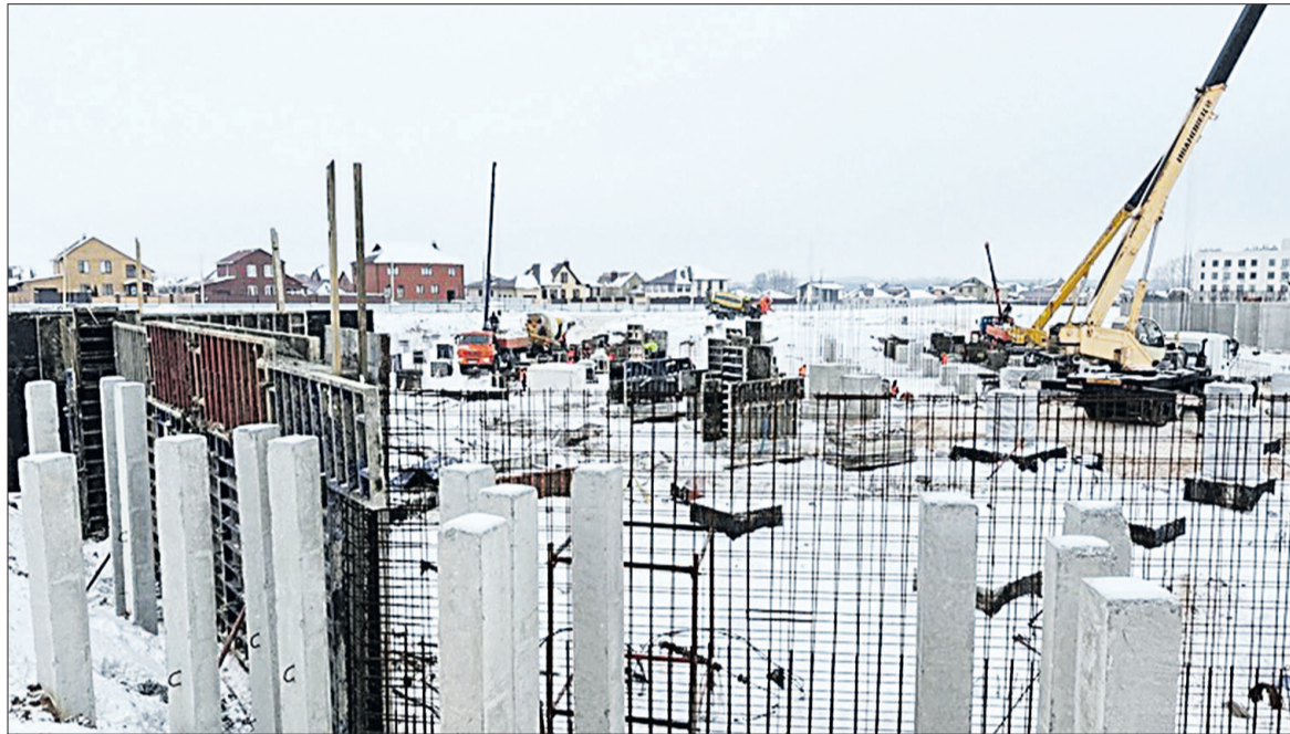
■ Строительство новой школы в Строителе уже вышло из нулевого цикла. / ФОТО: ПРЕСС-СЛУЖБА ГУБЕРНАТОРА И ГЛАВЫ ОКРУГА
