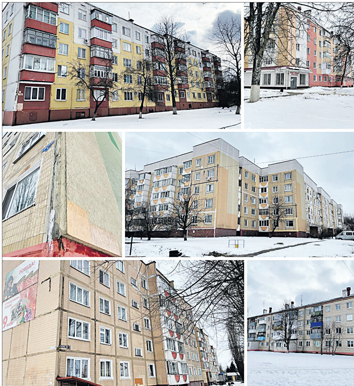
Эти многоквартирные дома попадают в 2023 году под программу капремонта. / ФОТО: Р. ОЖЕГОВА
